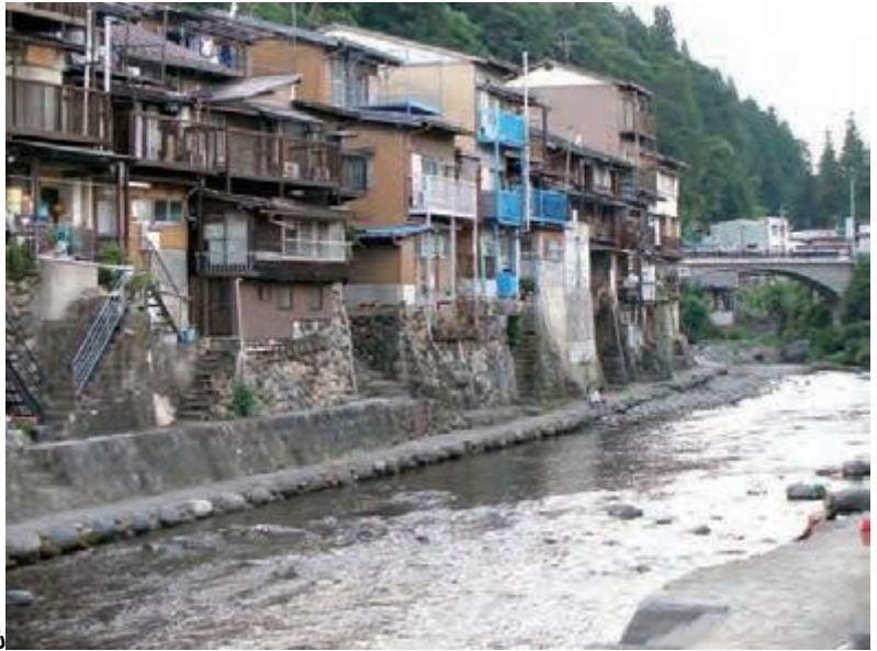
شکل ۱۴- عدم رعایت حریم آب
